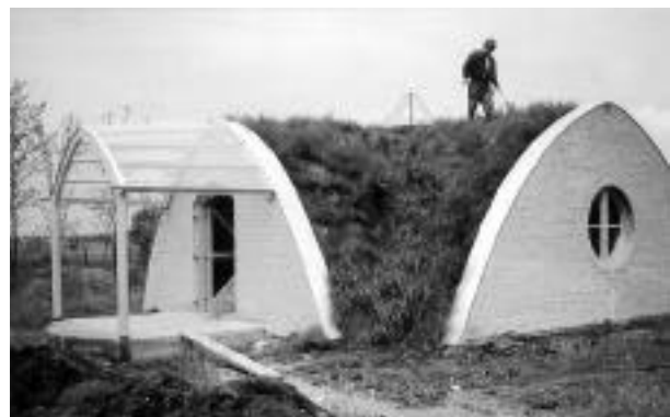
A földház építés egyik magyarországi kifejlesztett változata az un. BIOÖKO építési rendszer. A felső képen a Hatvan közeli Lentiben épülő együttes szerkezetkész épületei láthatók. Az alsó kép a tető zöldesítését mutatja.
